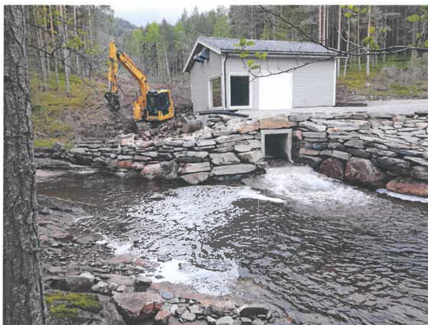
Trontveit kraftverk opna 29.05.2019, damtypa er eit Coandainntak. (Foto: Aslak Ofte)
